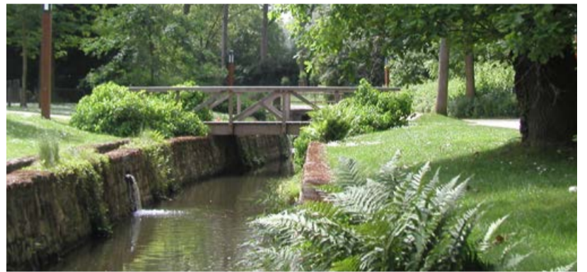
Timber bridge, Bridge, Vallee de Woluwe
